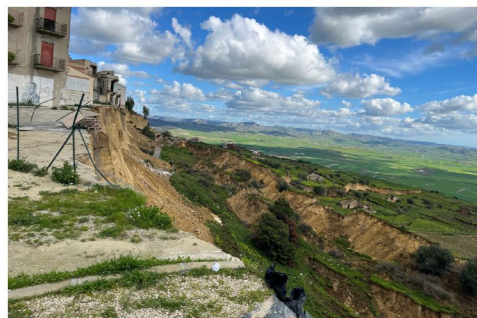
Figura 14 - Scivolamento composto con attivazione di superfici di taglio interne in materiali a fragilità moderata e formazione di Graben (Hutchinson, 1988). A destra sono visibili due foto dell'ampio Graben formatosi sotto la scarpata principale della frana di Niscemi.
