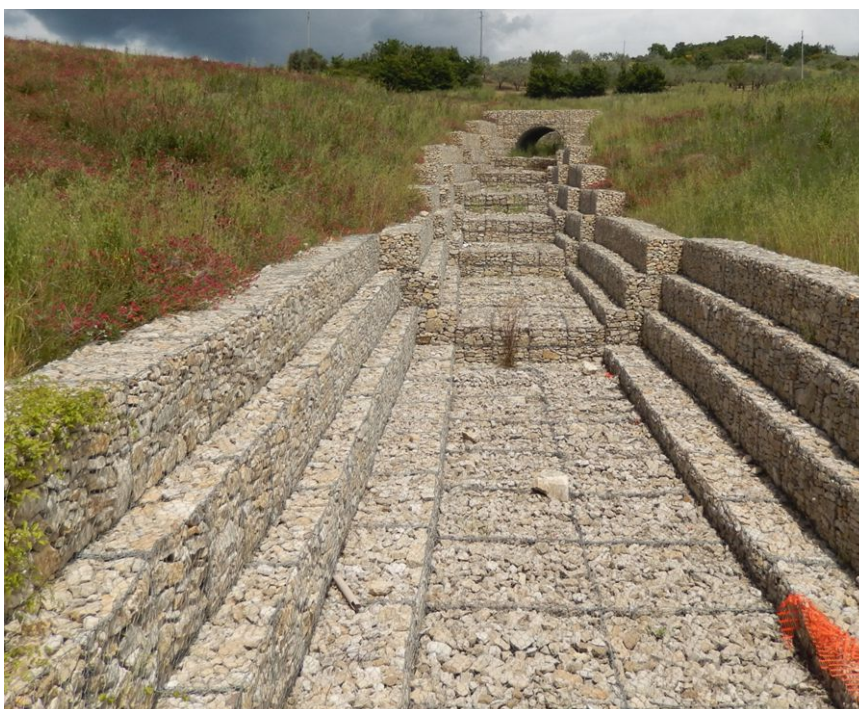
Figura 192 - Sistemazione alveo e sponde mediante utilizzo di gabbioni metallici riempiti con materiale lapideo su un canale della frana di Montaguto (AV).
