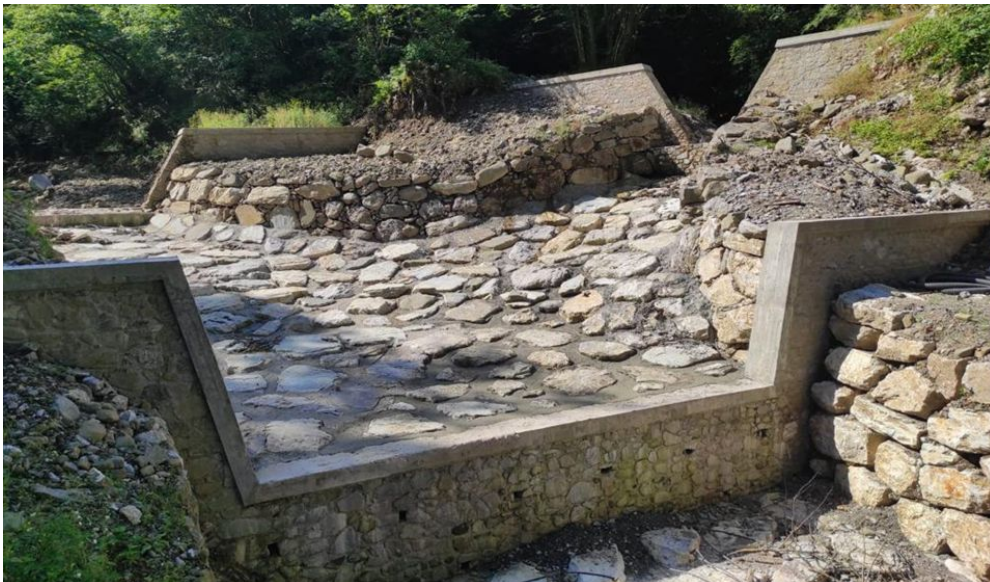
Figura 190 - Briglia in calcestruzzo armato su fondazioni profonde - Solco del Diavolo, Alta Garfagnana (LU).
