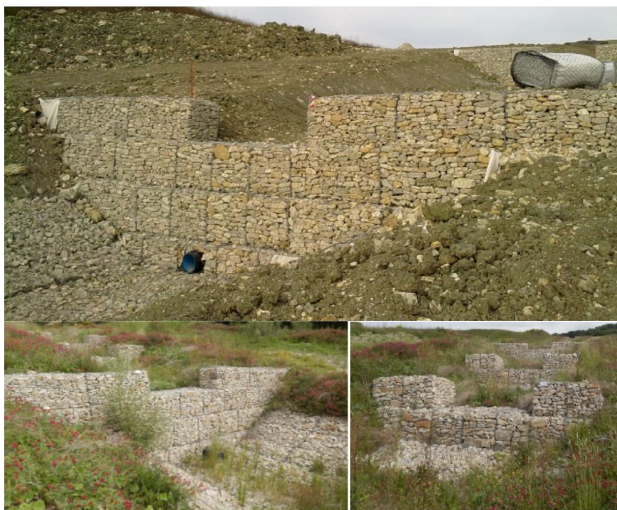
Figura 195 - Esempi di realizzazione di briglie in gabbionate metalliche riempite con materiale lapideo nei pressi della frana di Montaguto (AV).
